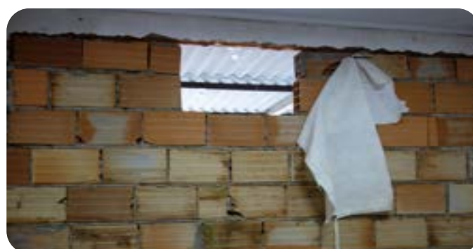
ÁREA DE ABERTURA PEQUENA EM RELAÇÃO À ÁREA TOTAL DO CÔMODO
