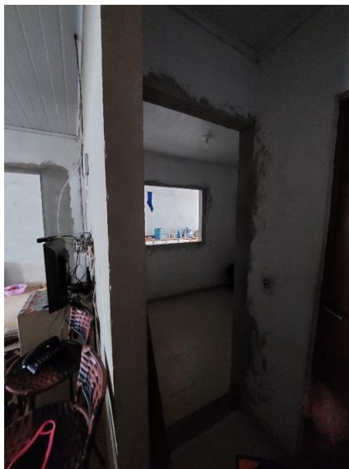
Figura 25: Aberturas só no “vão” na casa C130, esperando recurso para encomendar caixilharia.
