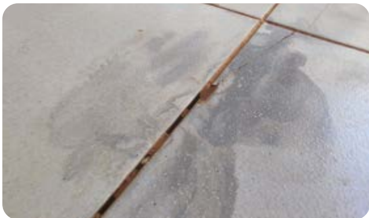
REJUNTE FALHADO PROVOCA MANCHA
