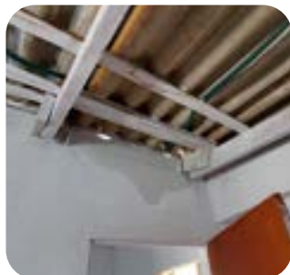
MANCHAS ESCURAS INDICAM ABSORÇÃO INDEVIDA DE ÁGUA
