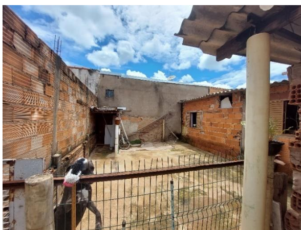
Figura 28: Muros externos e paredes sem reboco e pintura.
