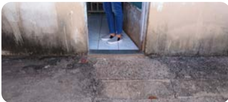
INFILTRAÇÃO ASCENDENTE
