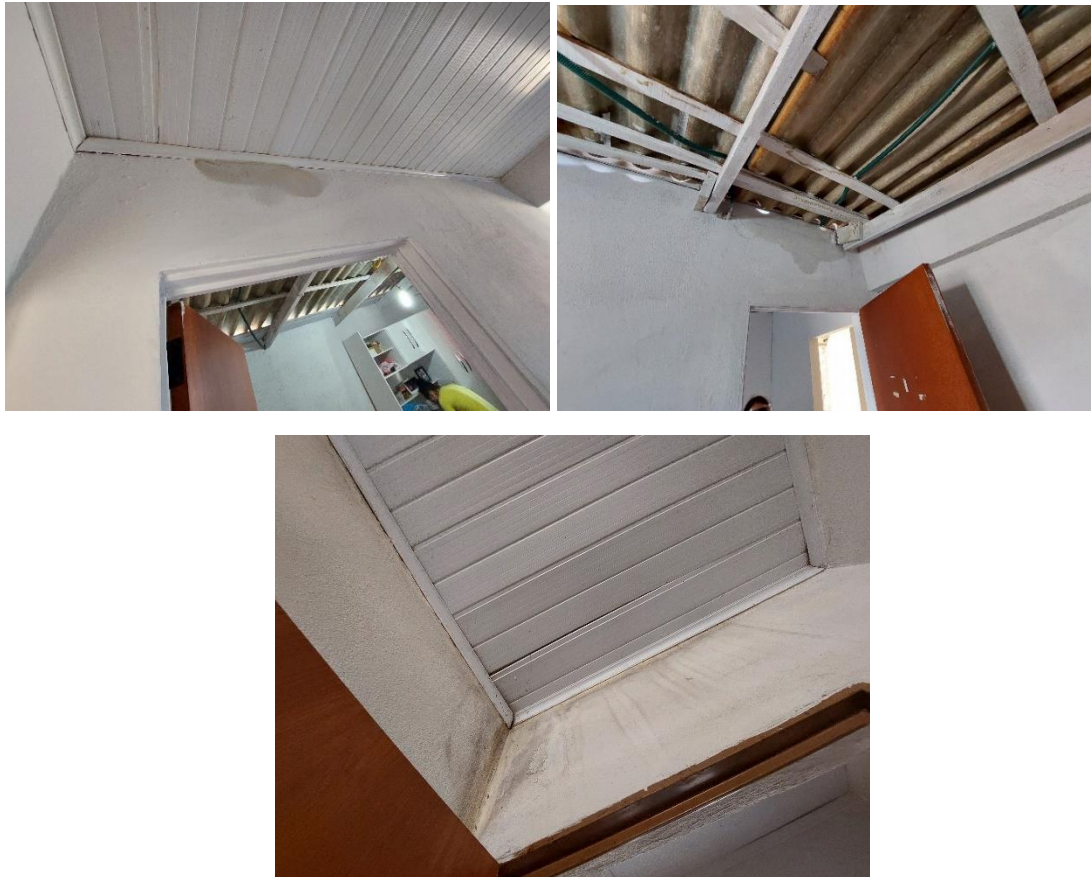
Figura 36, Figura 37 e Figura 38: Infiltrações e mofo em ambientes originais e criados.
