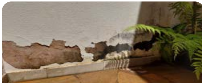
PINTURA PERDIDA DEVIDO A ABSORÇÃO DE ÁGUA
