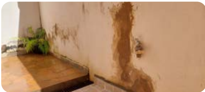
CANOS RACHADOS UMECEM A PAREDE POR DENTRO
