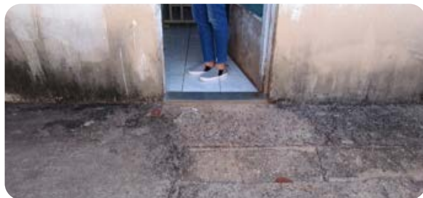
INFILTRAÇÃO ASCENDENTE
