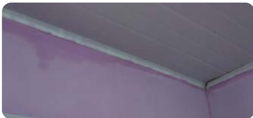
MANCHAS ESCURAS INDICAM ABSORÇÃO INDEVIDA DE ÁGUA
