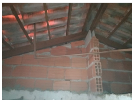
Figura 13: Frestas entre parede geminada e telhado.
