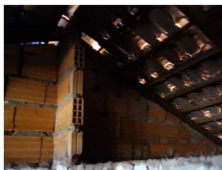
Figura 15: Frestas entre parede geminada e telhado.
