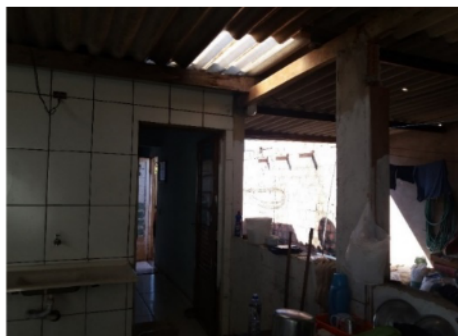
Figura 20: Telha translúcida em ampliação no fundo.
