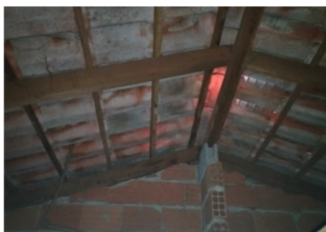
Figura 12: Frestas entre parede geminada e telhado.
