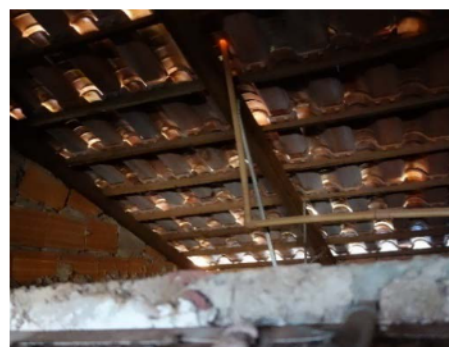
Figura 11: Telhas deslocadas e danificadas.
