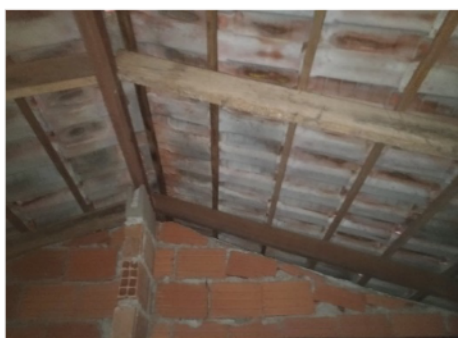
Figura 14: Frestas entre parede geminada e telhado.
