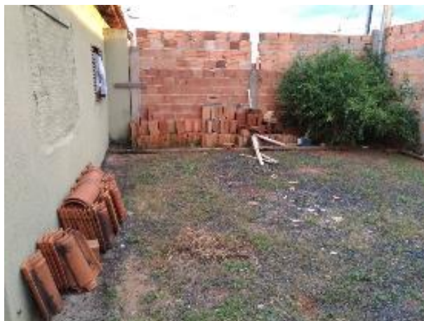
Figura 24 - Estocagem inapropriada de materiais construtivos
