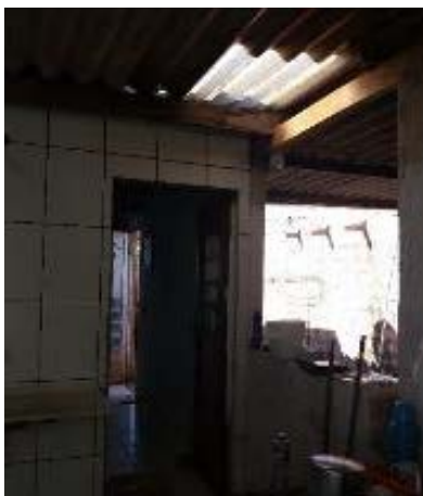
Figura 36 - Telhas translúcidas na porção posterior de uma casa
