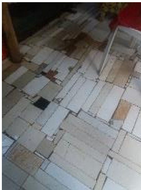
Figura 42 - Utilização de materiais reaproveitados de pavimentação
