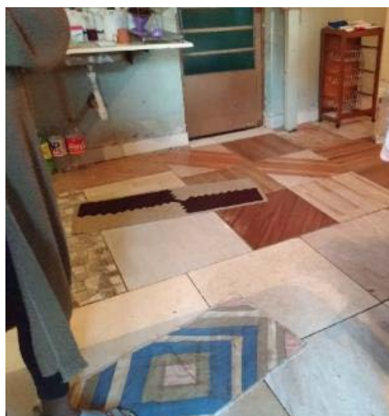
Figura 41 - Utilização de materiais reaproveitados de pavimentação
