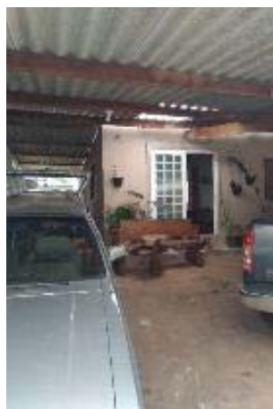
Figura 35 - Telhas translúcidas na porção frontal de uma casa
