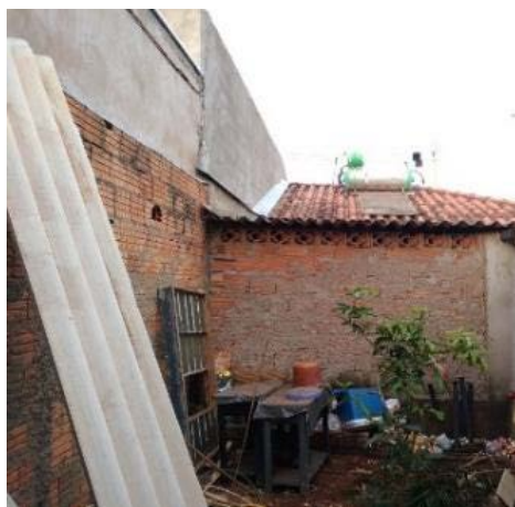
Figura 41 - Utilização de materiais reaproveitados de pavimentação
