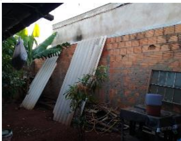
Figura 23 - Estocagem inapropriada de materiais construtivos
