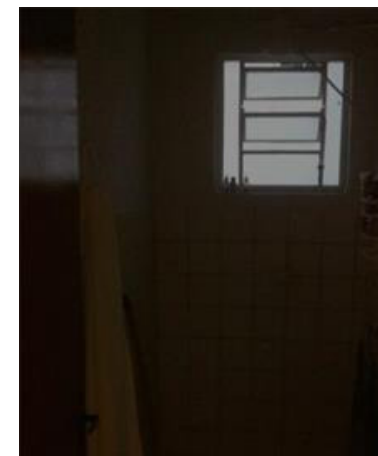
Figura 118 – Comprometimento da iluminação do banheiro após a construção de cobertura na área externa no Jardim Sucupira. Fonte: Acervo pessoal dos autores.
