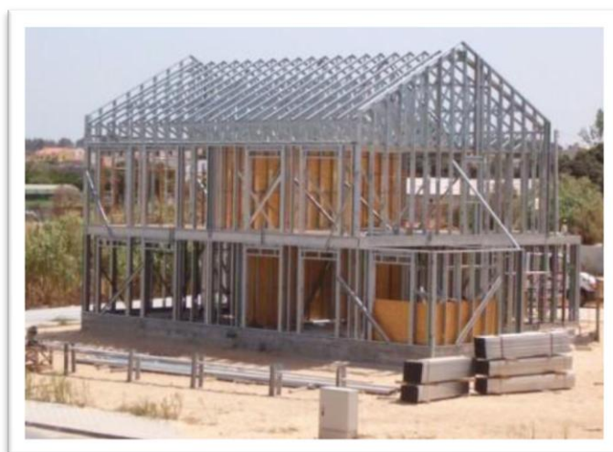
Figura 6- Sistema Steel Framing concluído. Fonte: Site www.metalica.com.br
