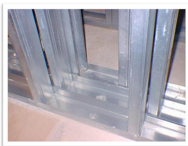
Figura 7 - Perfil de aço galvanizado. Fonte: Guia do Construtor em Steel Framing.
